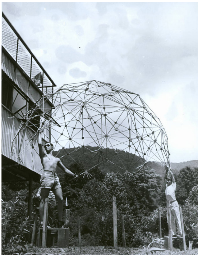
FIG. 14 : École d'été de 1949 du Black Mountain College : des étudiants de Buckminster Fuller font la démonstration de la légèreté du dôme. (Photographie : Masato Nakagawa). Avec l'aimable autorisation de Western Regional Archives, State Archives of North Carolina.
