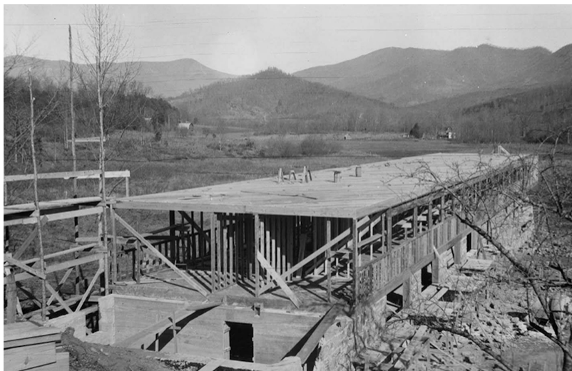
FIG. 12 : Construction du Bâtiment des études : le rez-de-chaussée vu depuis la future entrée, Black Mountain College, campus du Lac Eden, 1940-1941 (architecte : Lawrence Kocher). Avec l'aimable autorisation de Western Regional Archives, State Archives of North Carolina.
